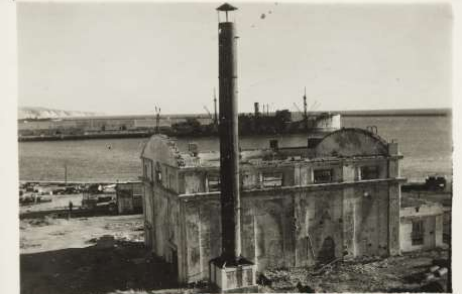
Буваремонтный завод. Капельница. (Северная сторона).
